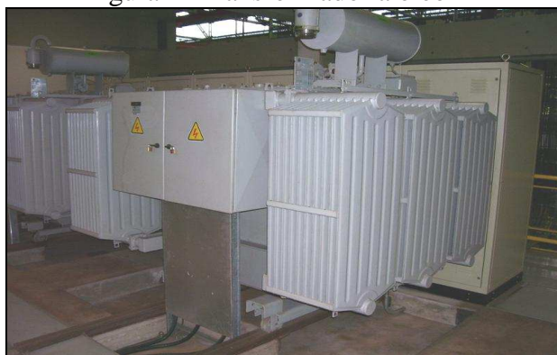
Figura 2- Transformador a óleo
