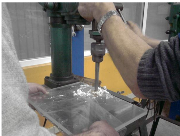
Figura 2. Perfuração das placas
