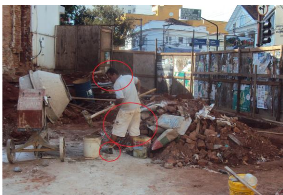
Figura 2. Falta de utilização de EPI's Obra 1- Empresa C
