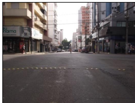
Figura 4: Vista Trecho 1, ausência de vegetação.
