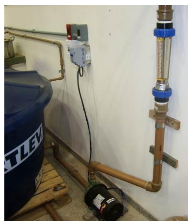
Figura 3: Sistema de cravação por jato de água
