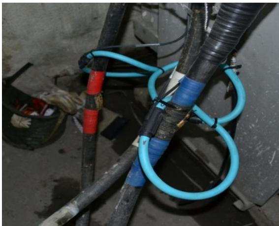
Figura 4 - Bobinas de Rogowski instaladas nos cabos isolados 15kV do primário do transformador.
