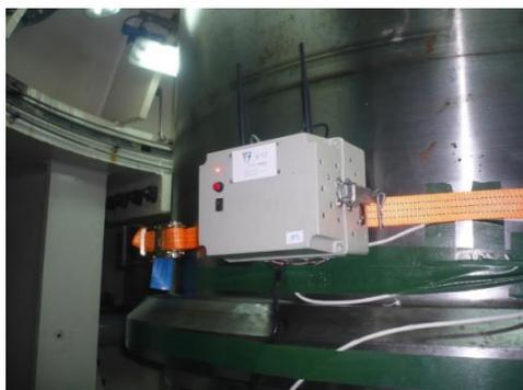
Figura 3 – Conjunto aquisidor, router e baterias solidárias ao eixo da turbina.
